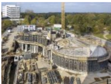
Baustelle neben der Uni Lübeck © GMSH
